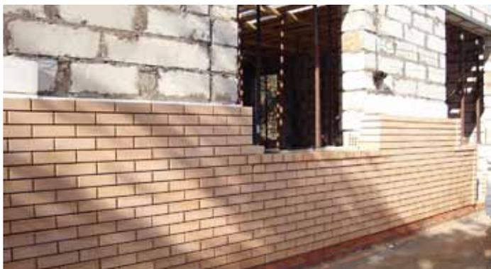
Установка базальтопластиковых гибких связей в стены, выполненные из ячеистобетонных блоков, при ведении кладки наружного облицовочного слоя (изменение архитектурного решения в процессе строительства)
