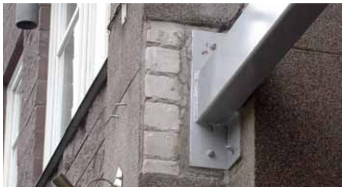
Монтаж несущих элементов рольставней к кладке из силикатного кирпича (повышение надежности крепления при заделке анкеров во второй ряд кирпичной кладки)
